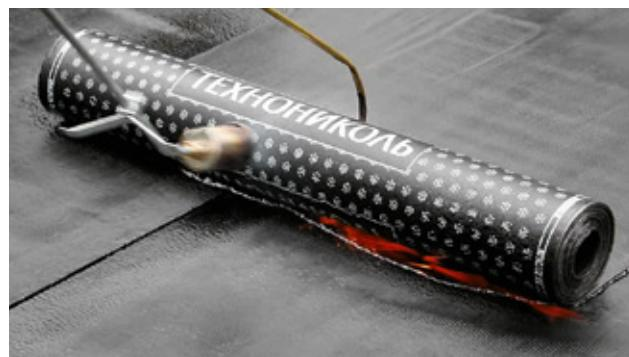
Рис. 10.5. Валик расплавленного битумно-полимерного вяжущего
